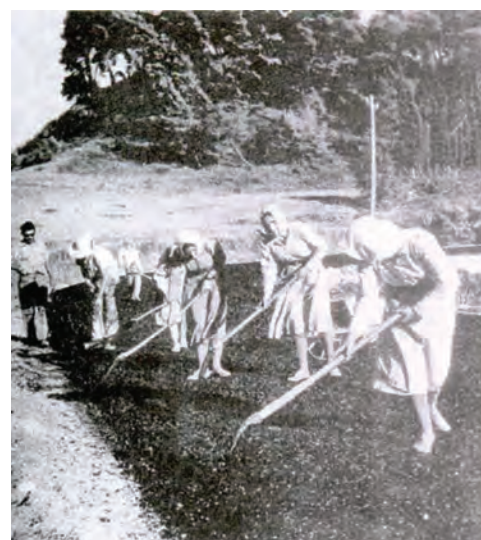
Κατασκευή δρόμου στην Ηγουμενίτσα, 1957, Σπύρος Μελετζής. Φωτογραφία 1923-1991, Βιέννη 1992, σ. 133.
