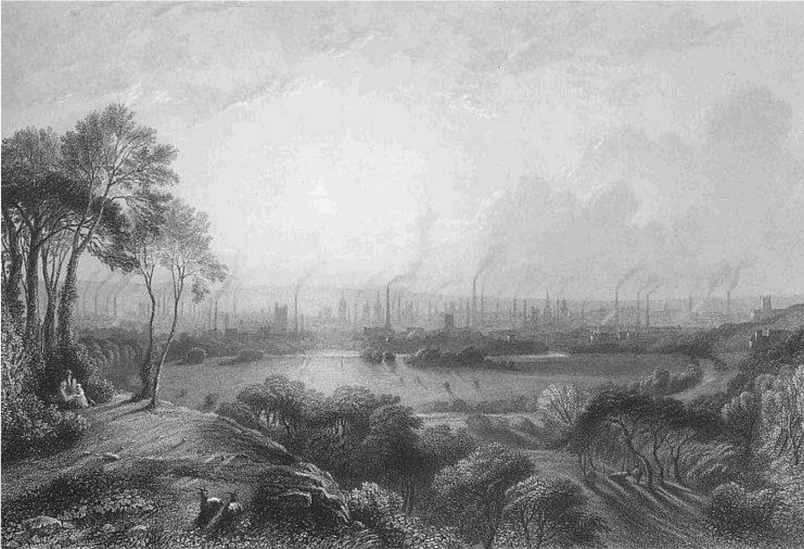
Πλήθος καμινάδων εργοστασίων στην θέα του Μάντσεστερ από μακριά, 1840.
