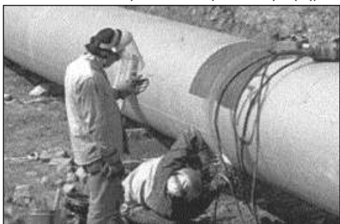
Εικόνα 7.1.8 Κατασκευή αγωγού μεταφοράς φυσικού αερίου στη Σιβηρία
