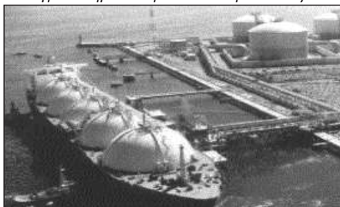
Εικόνα 7.1.7 Εγκαταστάσεις μεταφόρτωσης υγροποιημένου φυσικού αερίου στις ΗΠΑ
