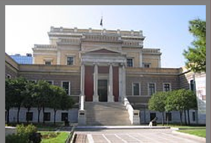
Το κτίριο όπου στεγάστηκε η Βουλή το 1875
