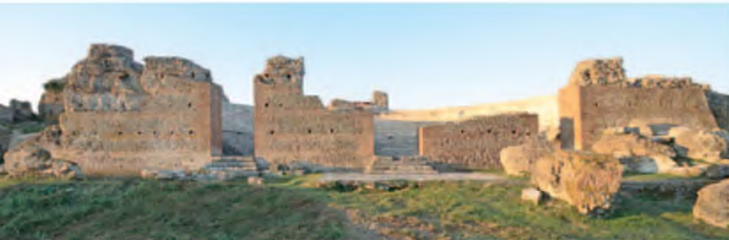
Η βόρεια πλευρά της σκηνικής πρόσοψης με μεικτή τοιχοποιία (opus mixtum)
