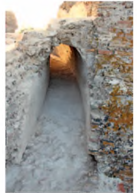
Τμήμα του περιμετρικού θολωτού αγωγού στο άνω κοίλο
