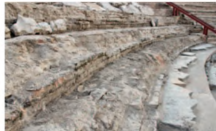
Στρώμα λιθοδέματος αρχαίας επέμβασης κατά μήκος της αρχικής στάθμης των εδωλίων του άνω κοίλου
