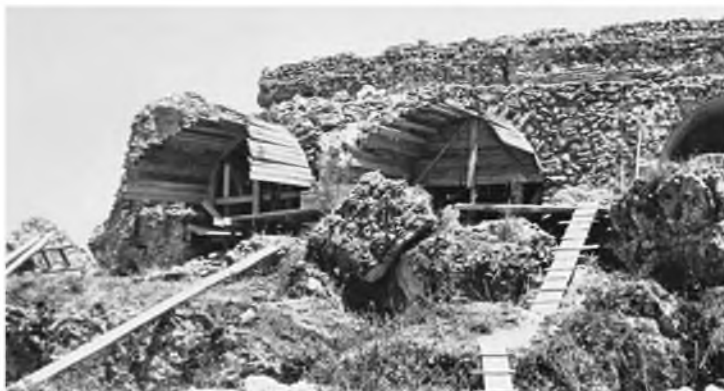
Εργασίες ανάκτη- σης των τόξων στους πεσσούς της περιμετρικής στοάς, 1971
