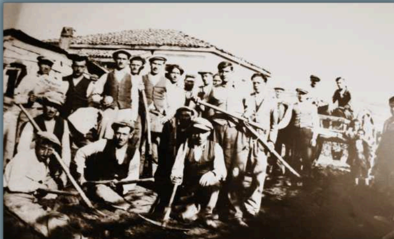
(Στη φωτογραφία: Κατασκευή των πρώτων δρόμων στα Προσφυγικά με τη συμβολή και προσωπική εργασία των προσφύγων, 1950)
